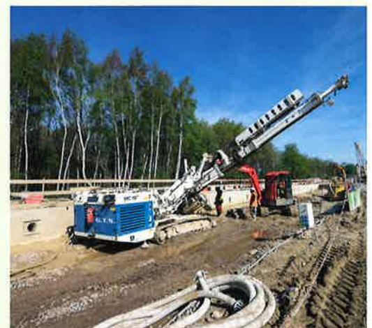
⬆ Mise en place des tirants
