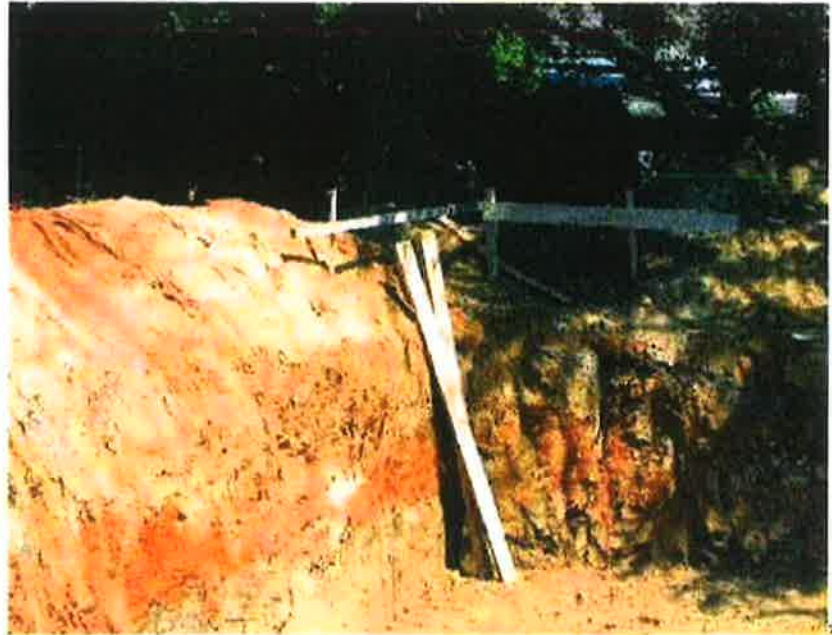
Ce ginkgo remarquable n'a pu échapper à la division du terrain en deux lots, qui a établi une nouvelle limite à proximité immédiate du tronc. Ses racines une fois amputées et détruites lors des terrassements, il n'a que peu de chances de survivre.
